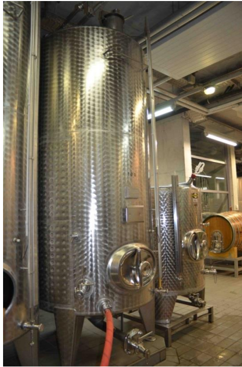
Abbildung 6: Tank zur Enzymierung und Vorklärung
